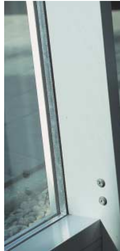
Das Fensterkreuz einer Stahlkonstruktion.
